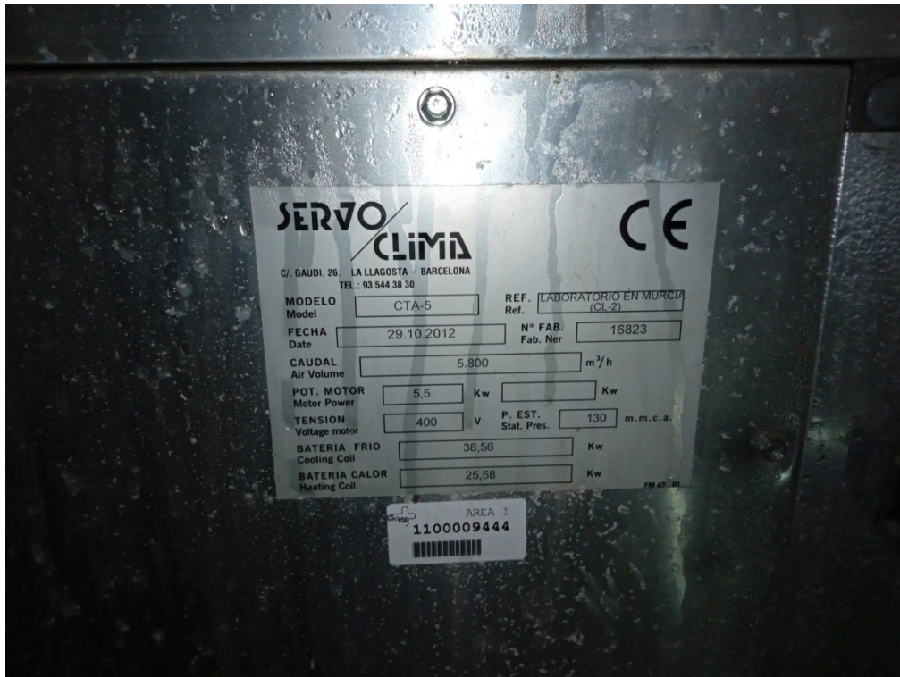
Fig. 8. Placa de características de Climatizador II.
