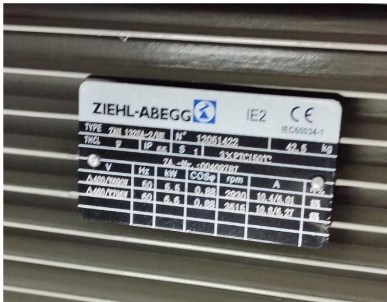
Fig. 11. Placa de características equipo motoventilador Climatizador II.
